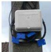
Les sous-répartitions optiques sont reliées par voie souterraine ou aérienne à des boîtiers également nommés points de branchements optiques (PBO) où la fibre est en attente. Ils sont positionnés dans une chambre souterraine ou sur un poteau, à une centaine de mètres des bâtiments (à l'intérieur des bâtiments pour les immeubles).
